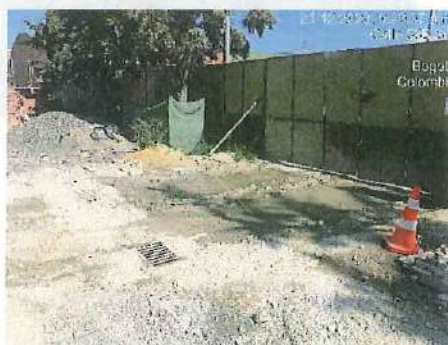
Se recomienda nivelar el terreno de entrada 2 para evitar empozamiento de agua. Fecha: 21-12-2023.
