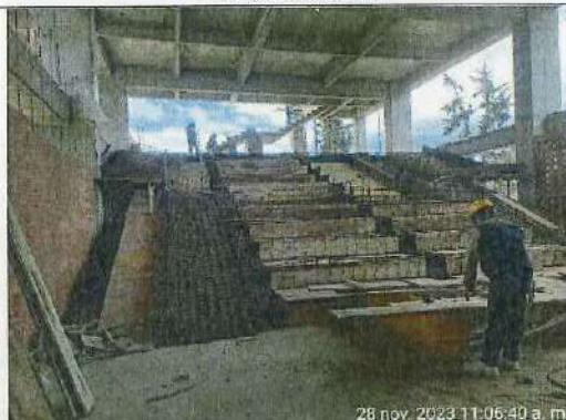
ARMADO DE COLUMNAS NIVEL 11.80 BLOQUE 2 - 28/11/2023
