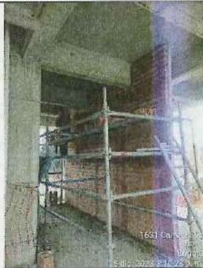
MAMPOSTERIA EN LADRILLO Y ENCOFRADO DE COLUMNAS BLOQUE 5 - 15/12/2023
