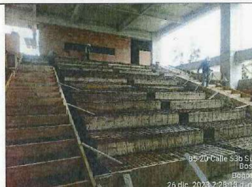
ARMADO DE ESCALERA NIVEL 0,00 AL NIVEL + 4,20 BLOQUE 2 - 26/12/2023
