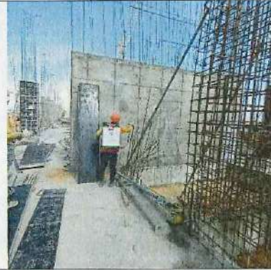
ARMADO DE ACERO COLUMNAS Y PANTALLAS NIVEL + 15,60 BLOQUE 2 - 14/12/2023
