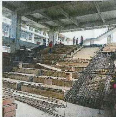
ACERO PARA PLACA NIVEL + 6,10 BLOQUE 7 - 11/12/2023
