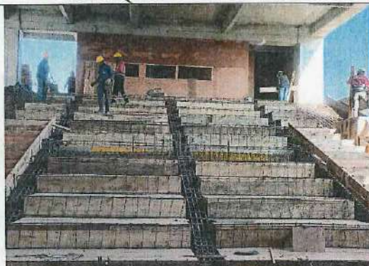
ARMADO DE ESTRUCTURA STEN NIVEL + 4,20 BLOQUE 7 - 20/12/2023
