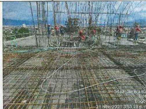
ARMADO DE ACERO Y COLUMNAS NIVEL + 11,80 BLOQUE 2 - 29/11/2023
