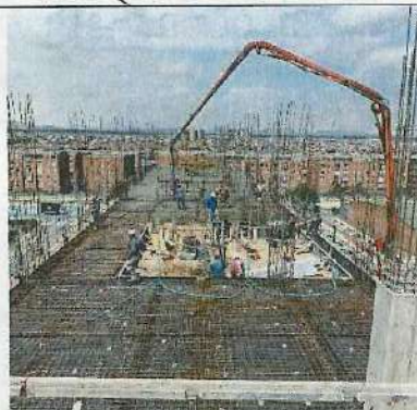
ARMADO DE ACERO PARA PLACA NIVEL + 4,20 BLOQUE 7 - 22/12/2023
