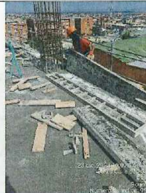
ARMADO DE ACERO PARA PLACA NIVEL + 4,20 BLOQUE 7 - 26/12/2023
