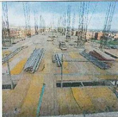
ARMADO DE ACERO PARA PLACA NIVEL + 6,10 BLOQUE 7 - 13/12/2023
