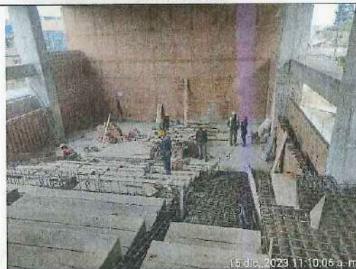
ARMADO DE ACERO PARA PLACA NIVEL + 15,60 BLOQUE 2 - 18/12/2023
