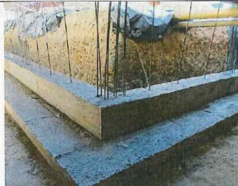
INICIO DE ARMADO ESTRUCTURA STEN NIVEL + 15,60 BLOQUE 2 - 04/12/2023
